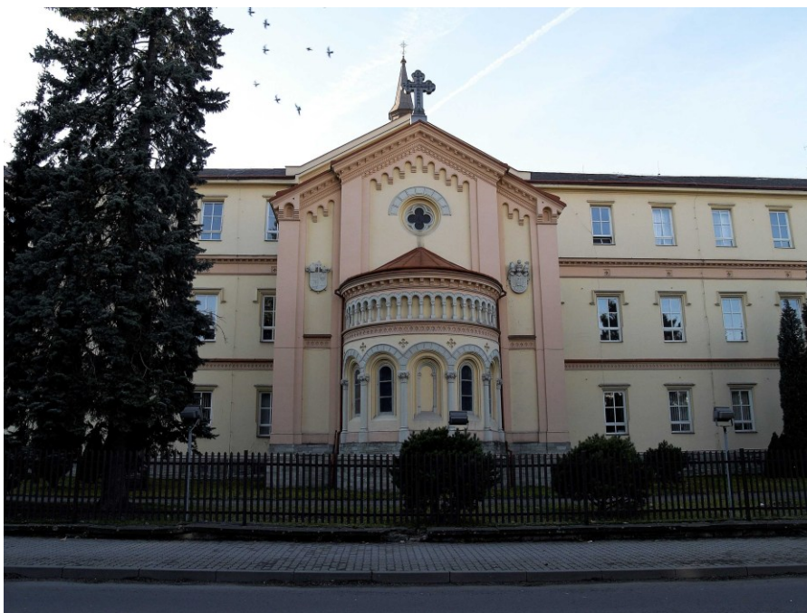
Budova Střediska sociálních služeb města Frýdlant nad Ostravicí
